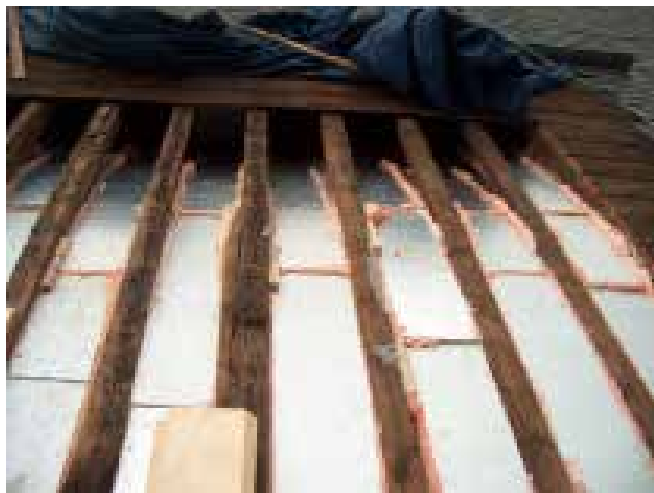
Het nageïsoleerde houten gewelf waarbij de zil-verkleurige PIR-platen en het roze PUR-schuim duidelijk zichtbaar zijn (foto: Marc Stappers, 2004)
