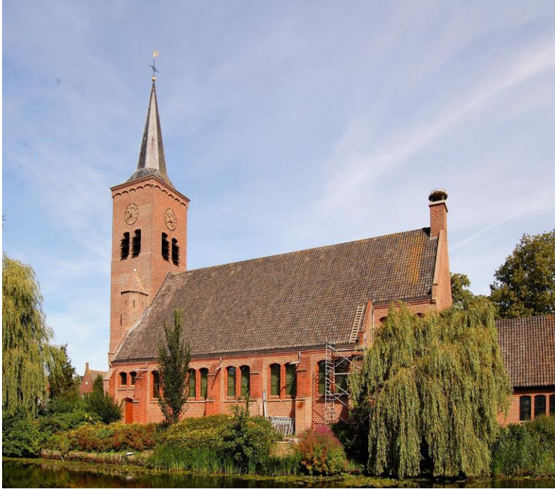
Kerkgebouw Hervormde gemeente te Bleskensgraaf, 1948.
