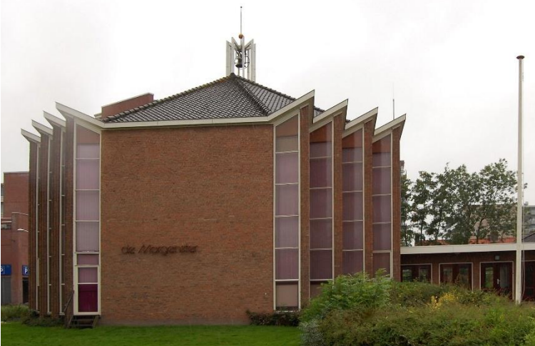
Gereformeerde kerk De Morgenster te Papendrecht, 1959.
