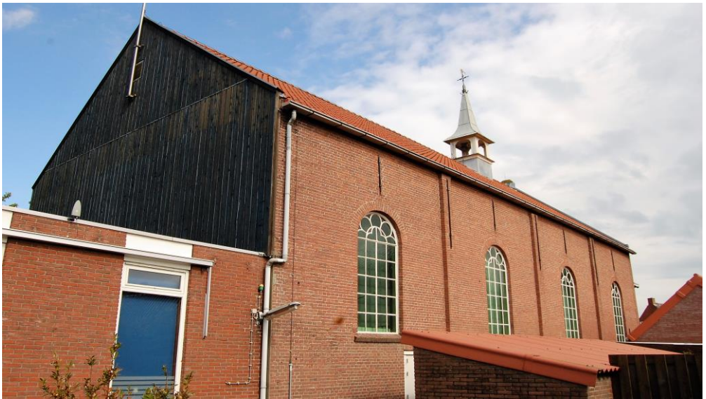
Kerkgebouw Gereformeerde kerk Strijen, 1892.
